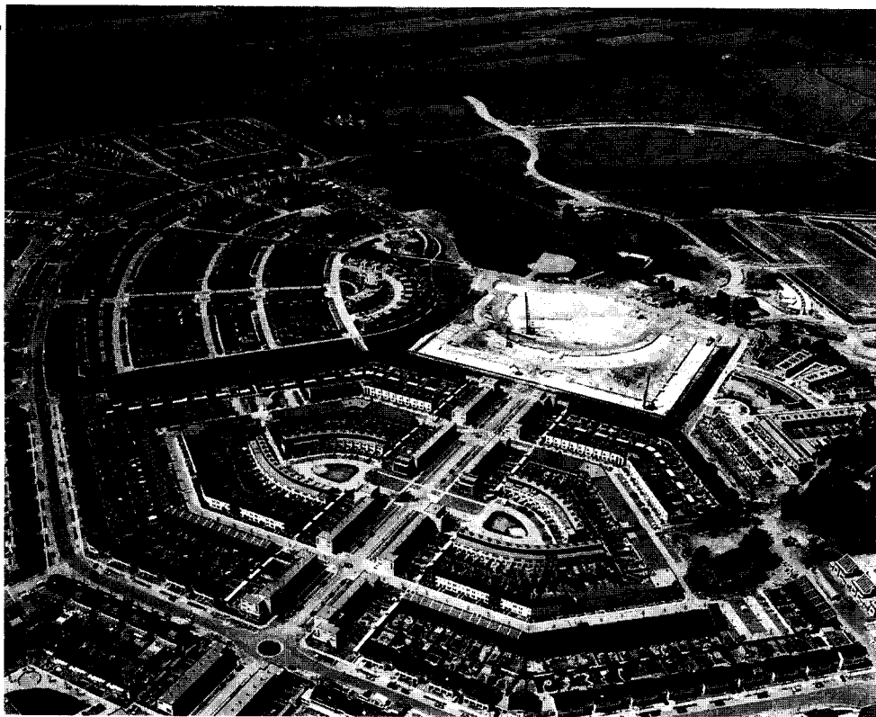
Amersfoort-Nieuwland: koppeling aan energievoorziening
